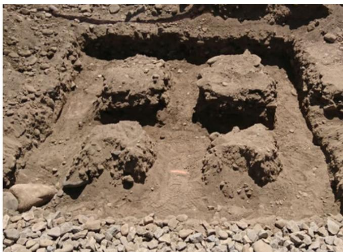
**1) Realice la excavación con las medidas requeridas para la instalación**
