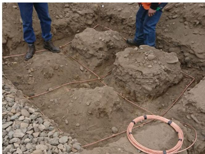
**2) Efectué la instalación de la malla a tierra.**
